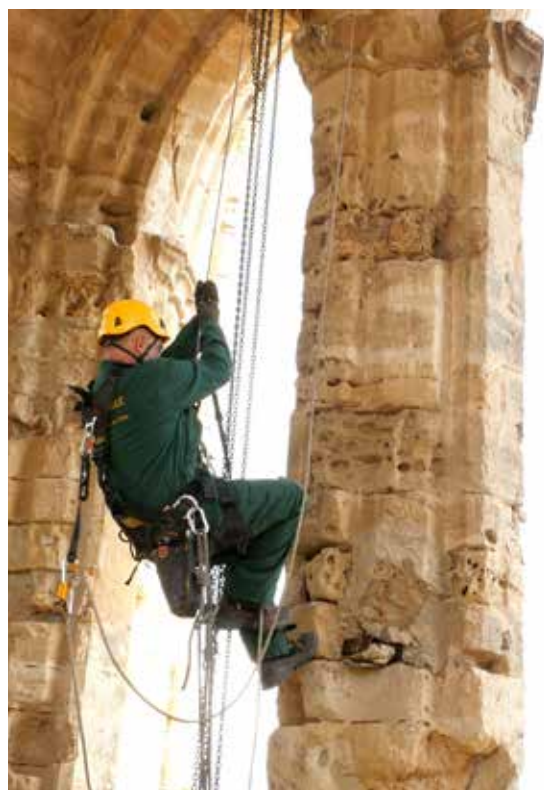
Début des travaux : analyse des pierres les plus abîmées
