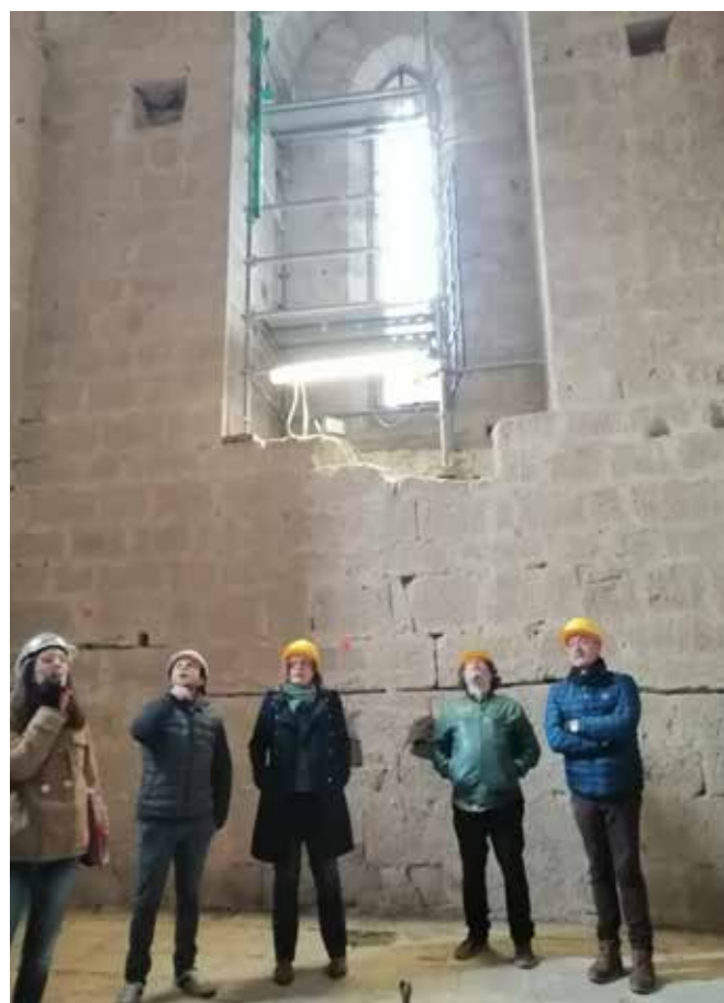
Visite du chantier par les élus de Lodève
