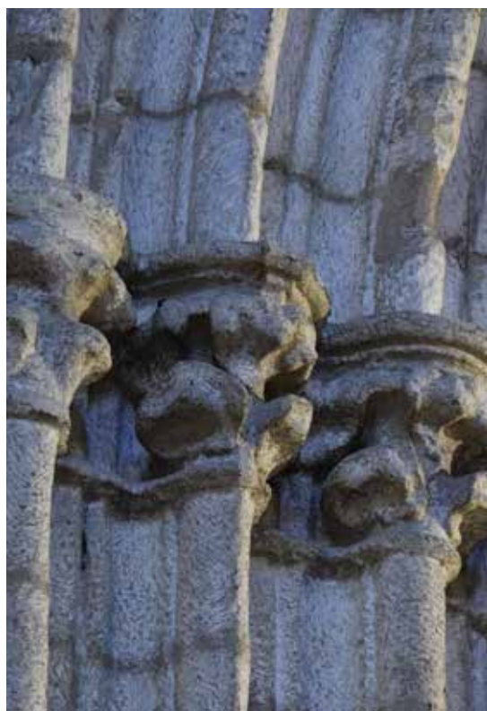
Détail d'arches gothiques - ©Mosaiques Archéologie
