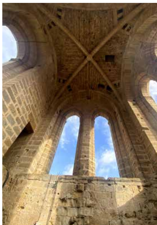
Vue de la voûte sur le 1er étage du clocher
