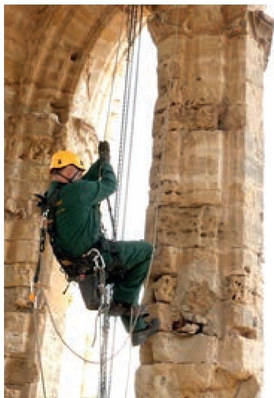
Début des travaux : analyse des pierres les plus abîmées
