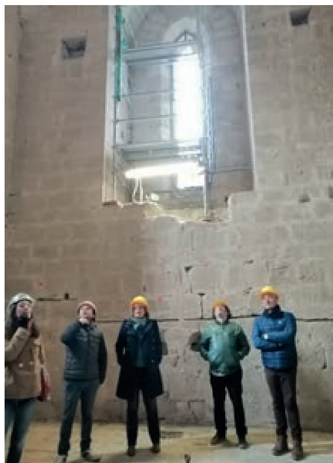
Visite du chantier par les élus de Lodeve
