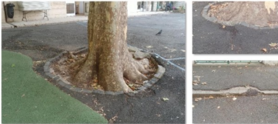
Déformation du terrain par les racines des platanes
